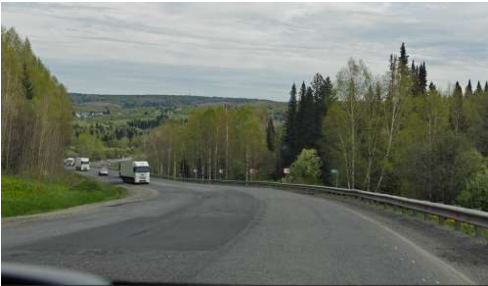
Крутые повороты на участке со свежим асфальтовым покрытием, разметка не нанесена.
