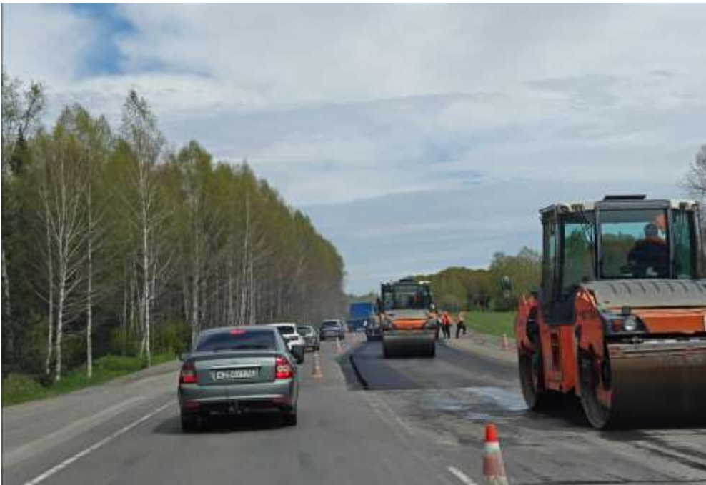
Ремонт дороги. На дороге работает спецтехника.
