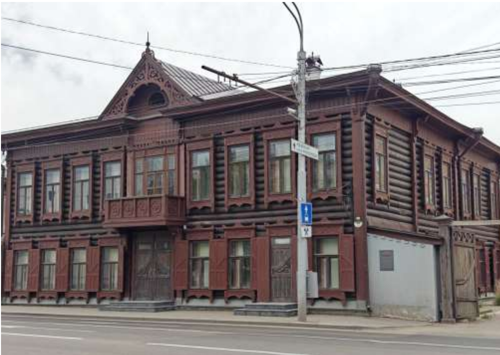
Жилой дом усадьбы купца О.К. Андреева (ул. Ленина, 84), построен в начале XX века, как главный дом усадьбы Объект культурного наследия регионального значения
