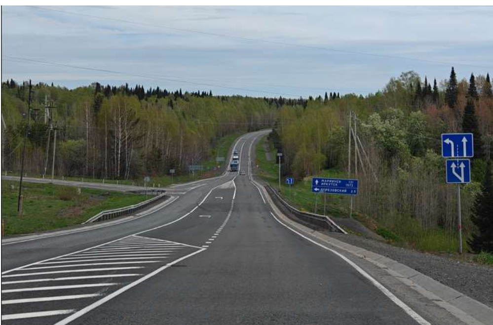
Характерные для данного участка спуски и подъёмы, отражающие рельеф местности, уклоны до 8%.
