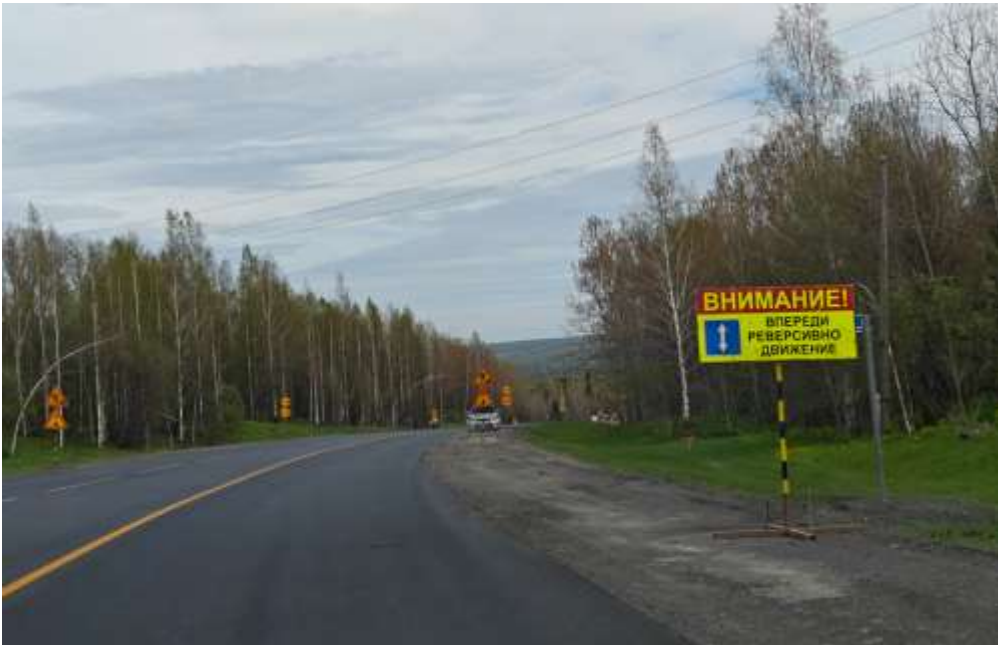
Ремонт дороги. Участки с реверсивным движением.
