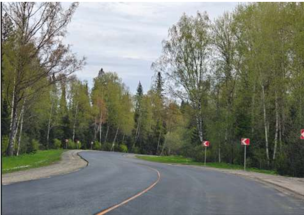
Свежее асфальтовое покрытие, нанесена временная разметка, крутые повороты.
