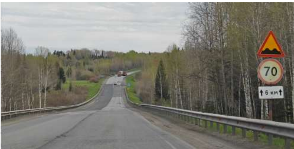
Неровности и заплатки на дороге.
