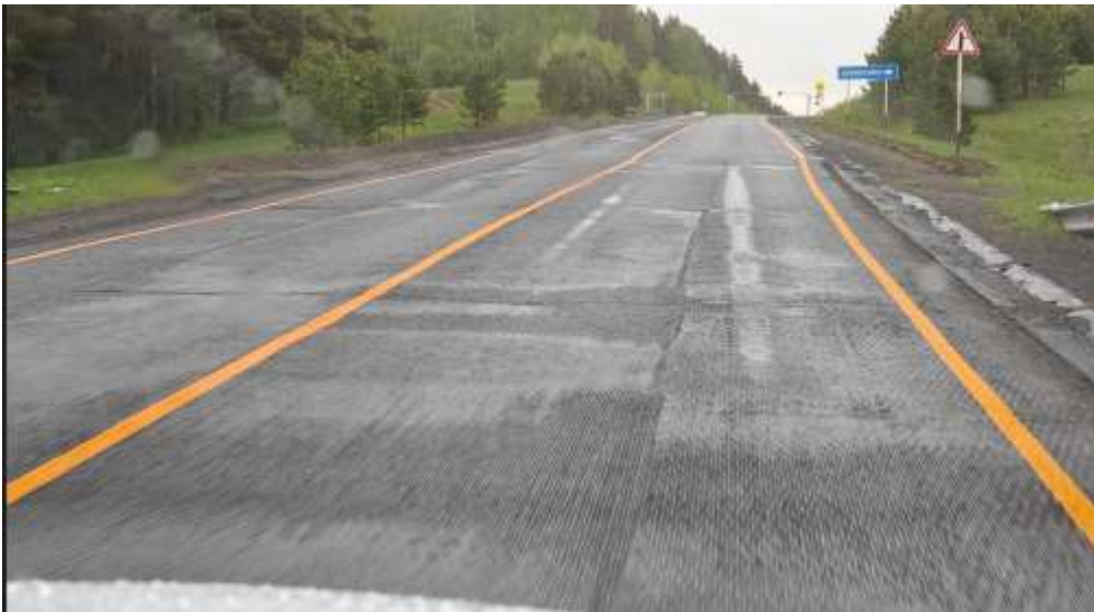
Участки дороги со снятым асфальтом и временной разметкой.
