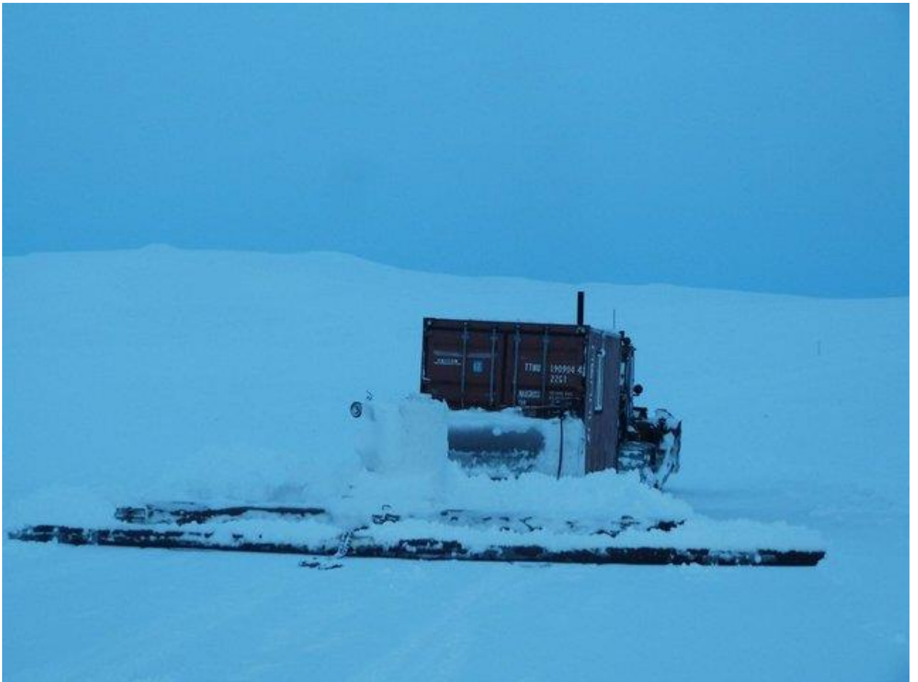
Фото № 13. Строительство зимника волокушей от г. Билибино до г. Певек
