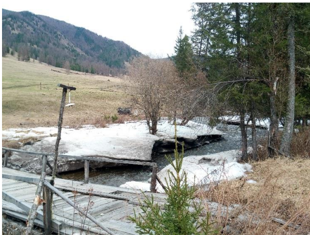
Мост через р.Айлагуш
