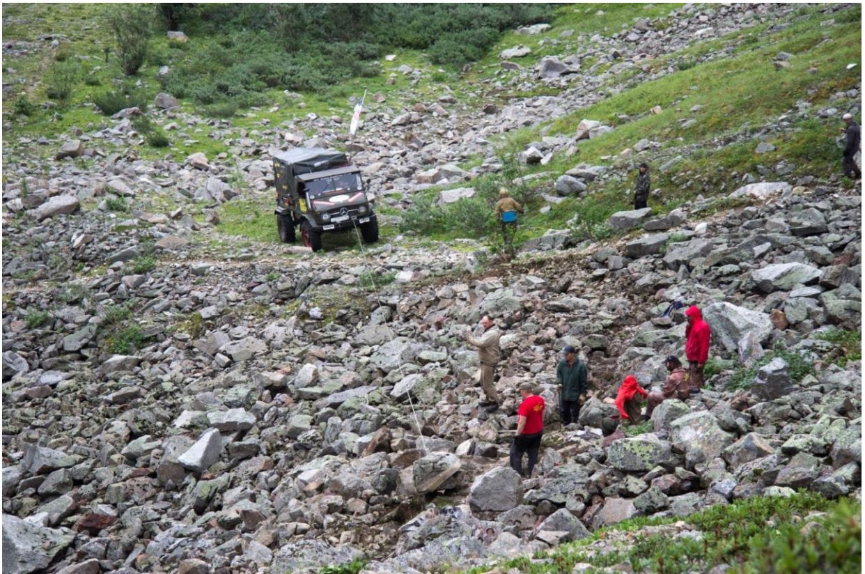
Большие камни разбивали убирали при помощи лебёдки.
