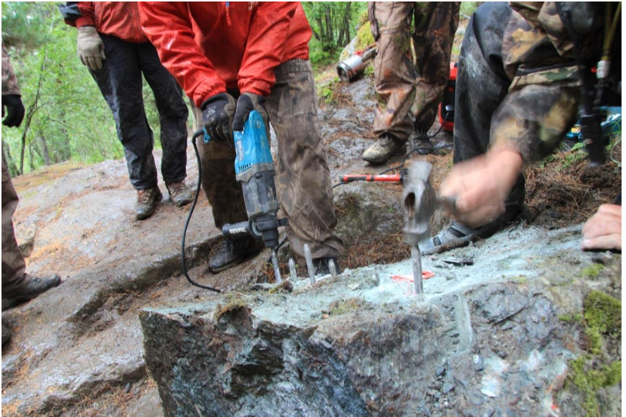
Удаление выступающего камня. перфоратор, камнекольные клинья, лопы.
