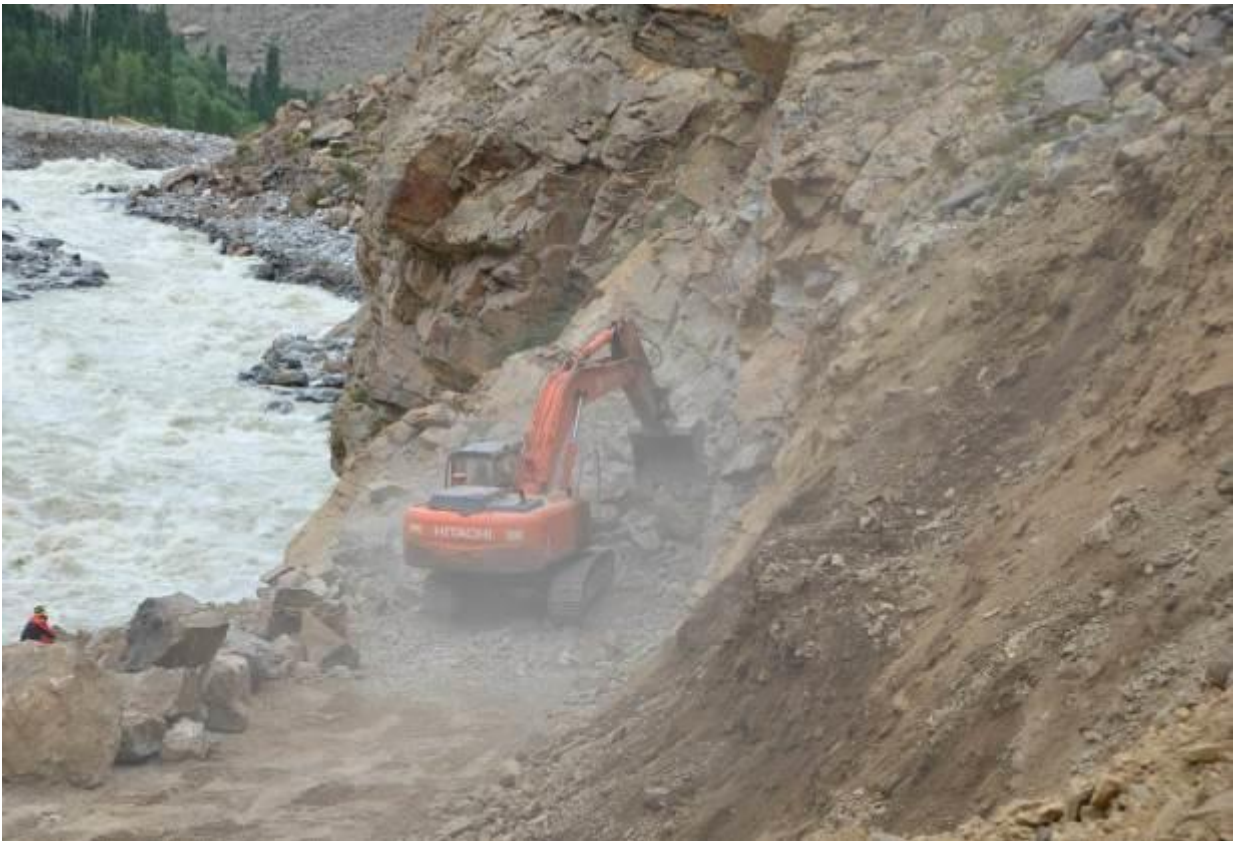
29. 27.07. Идет строительство новой дороги
