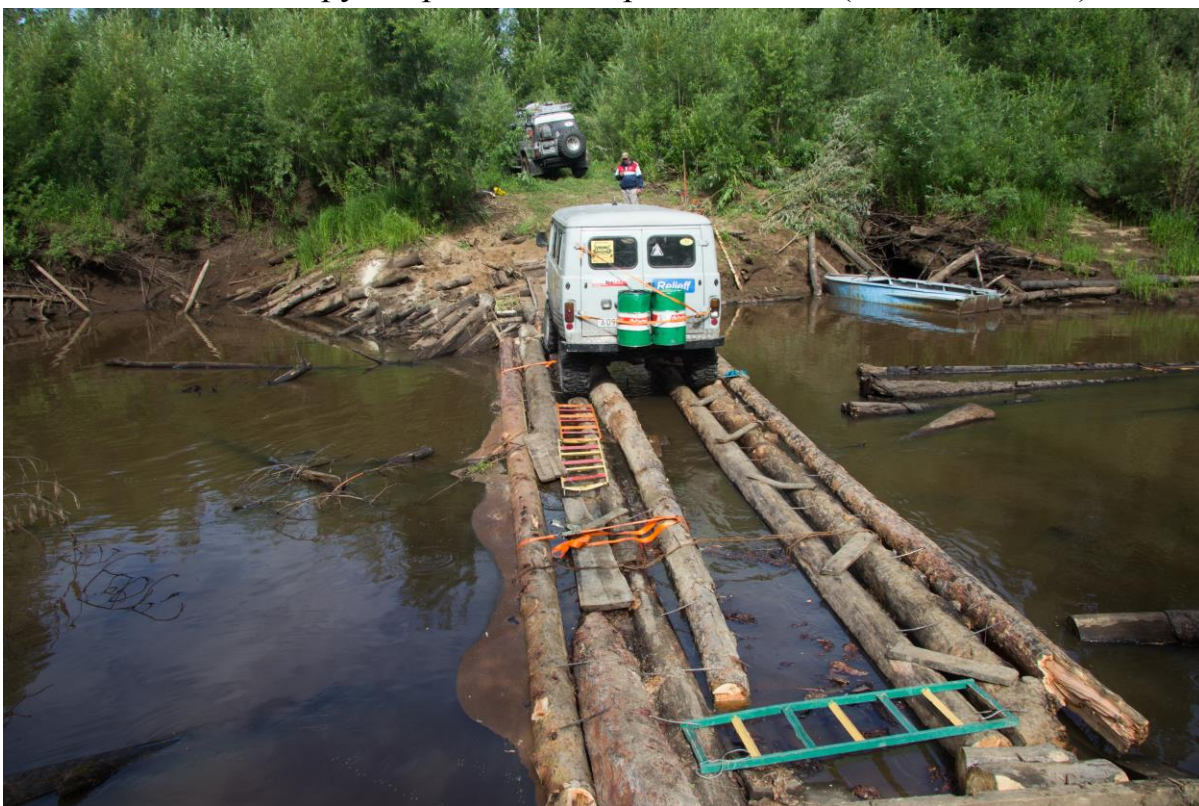
Мост после прохождения двух групп.
