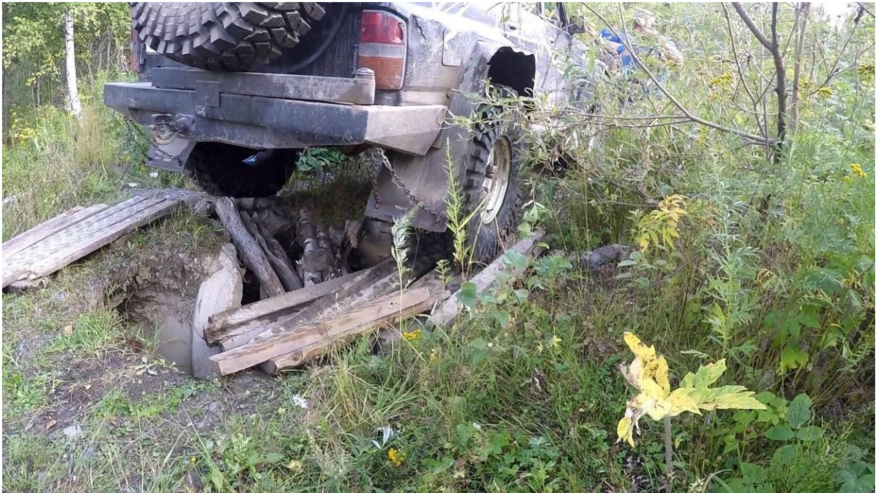
Разрушенный мостик через ручей
